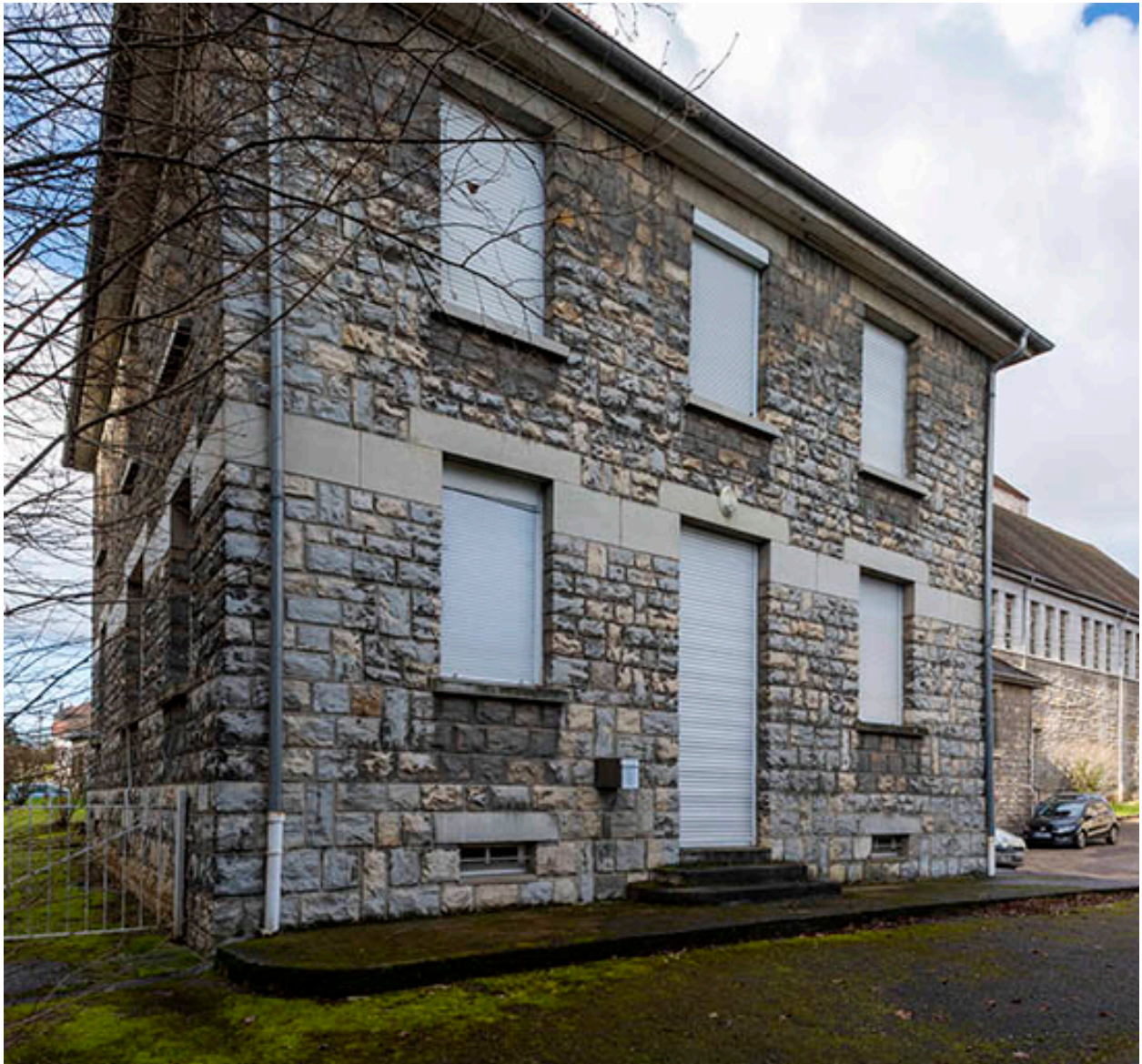
Façades sud et est du presbytère vues de trois quarts.
