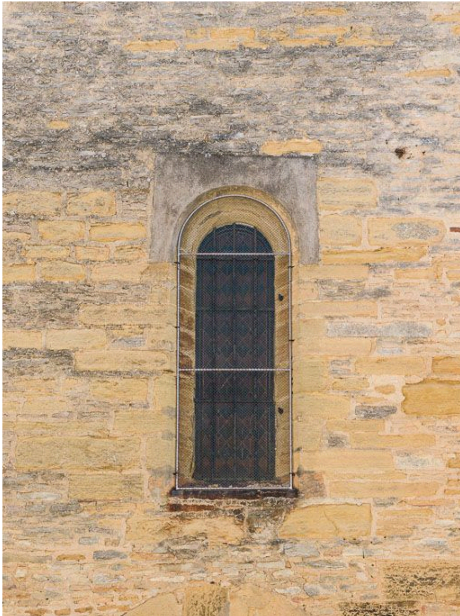
Façade : baie au dessus de la porte.
