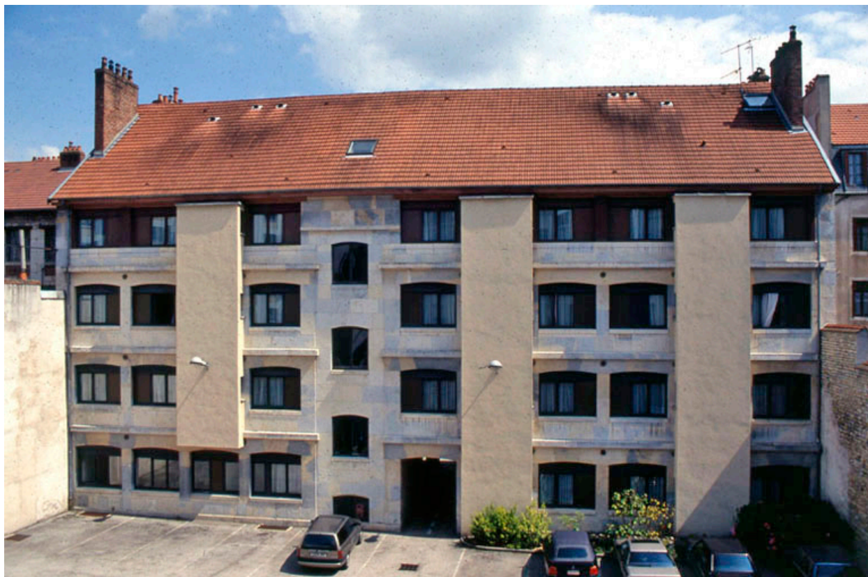
Façade postérieure en 1996.
