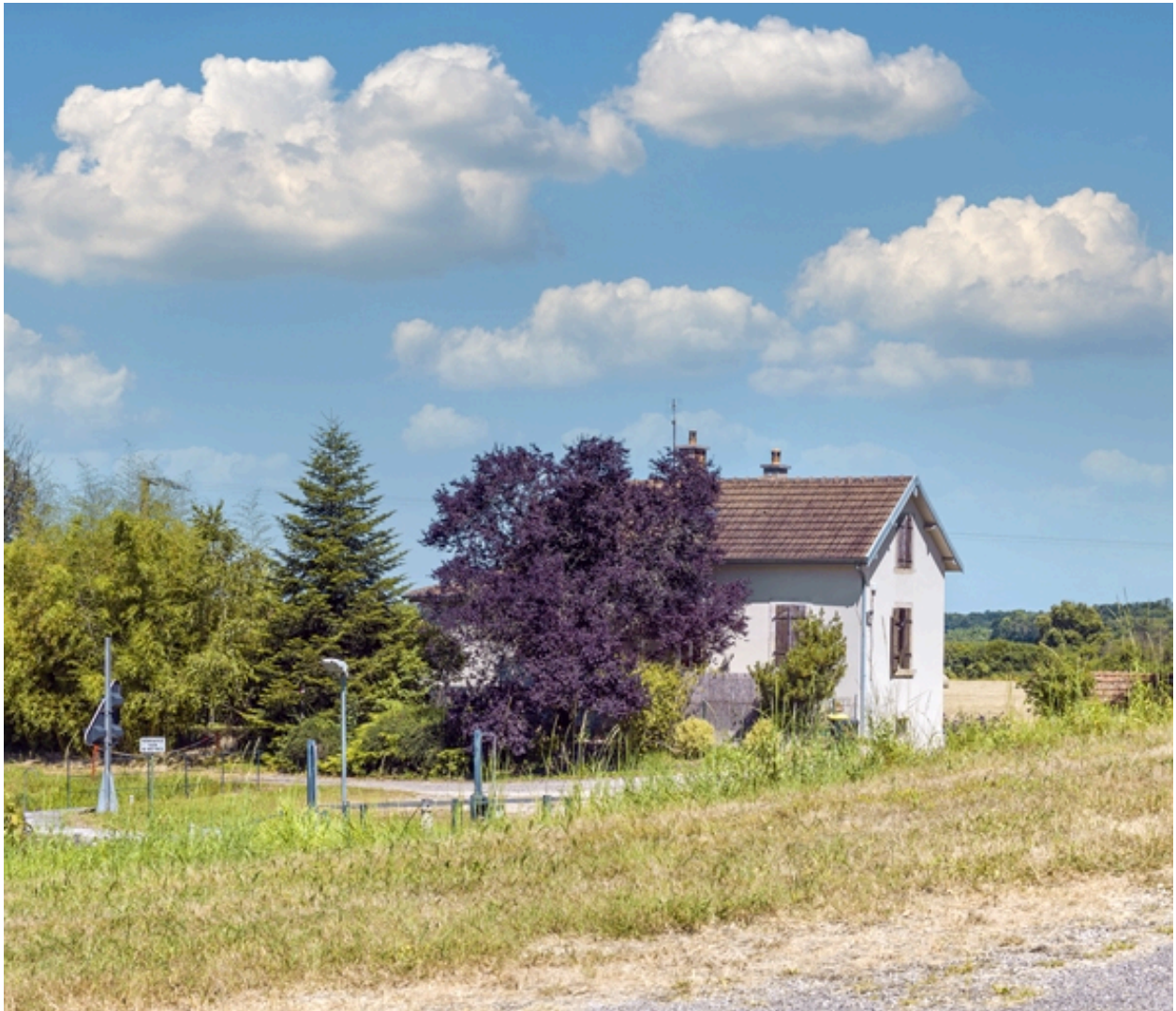
La maison éclusière de Poncey.
