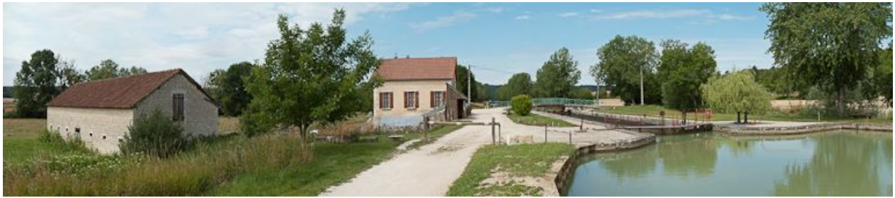
Site de l'écluse 94 du versant Yonne, dite d'Arcot, à Tonnerre : vue d'ensemble.
