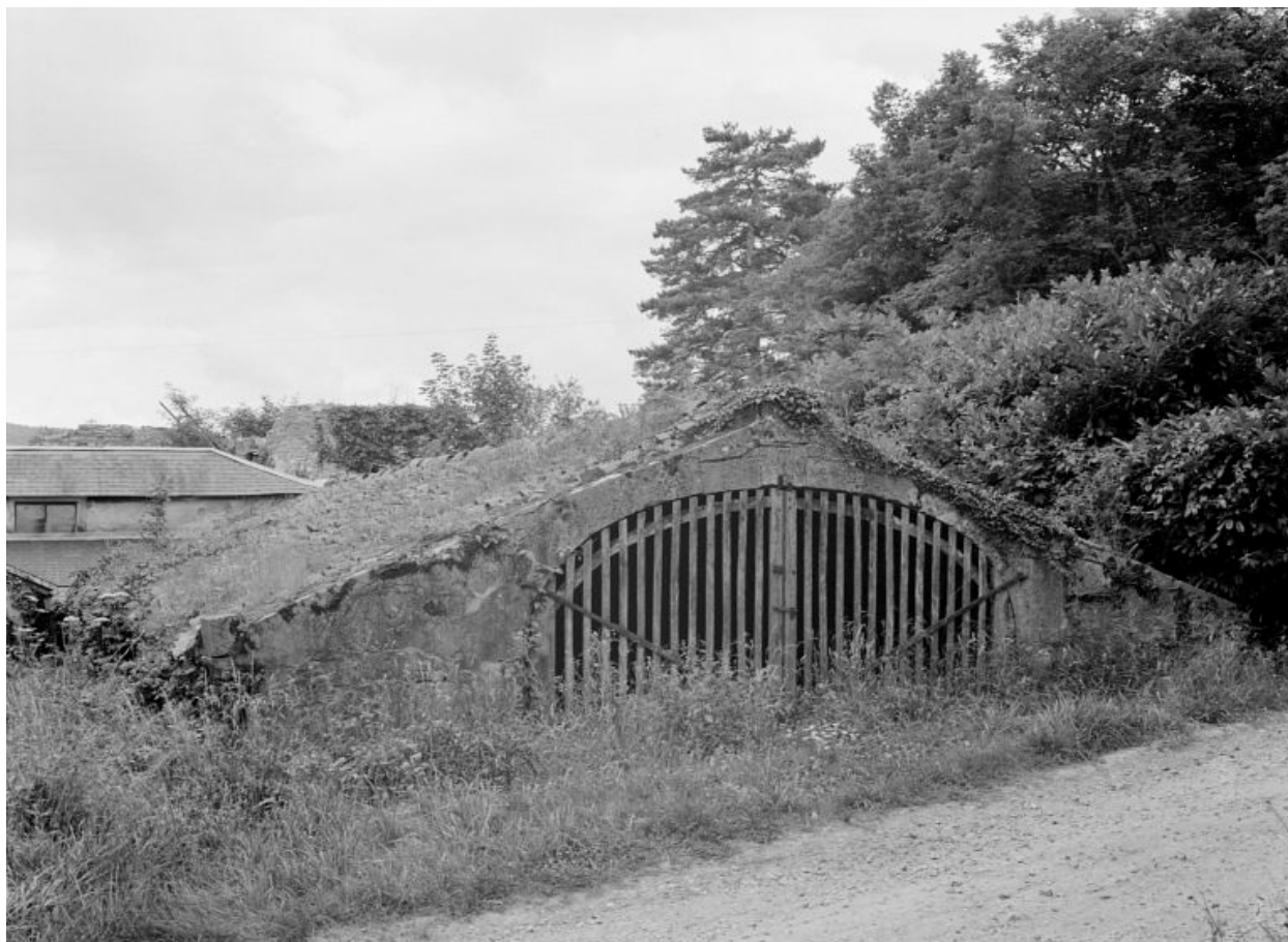
Cellier, vue prise en 1977.
