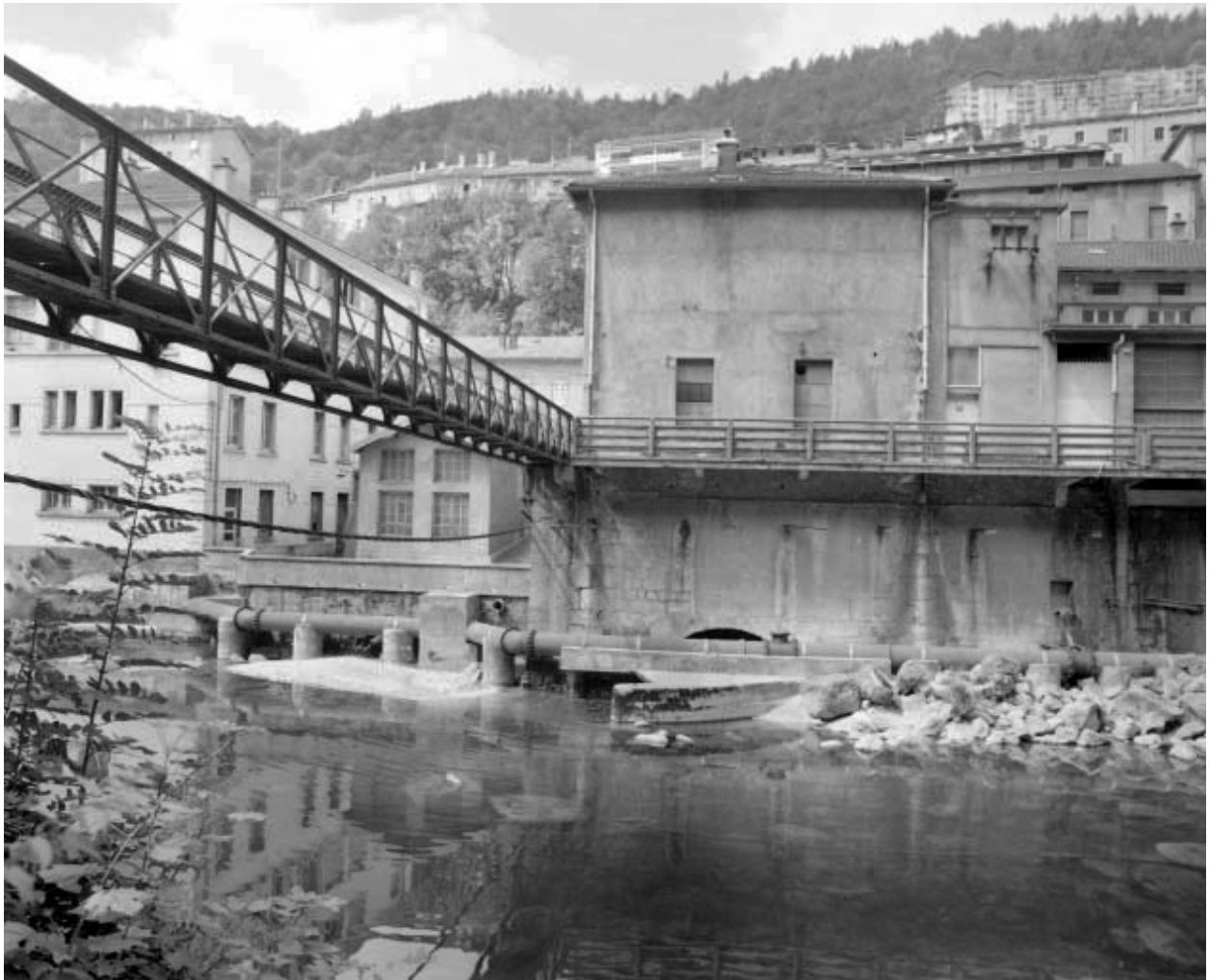
Diamanterie Dalloz : partie gauche de la façade postérieure.
