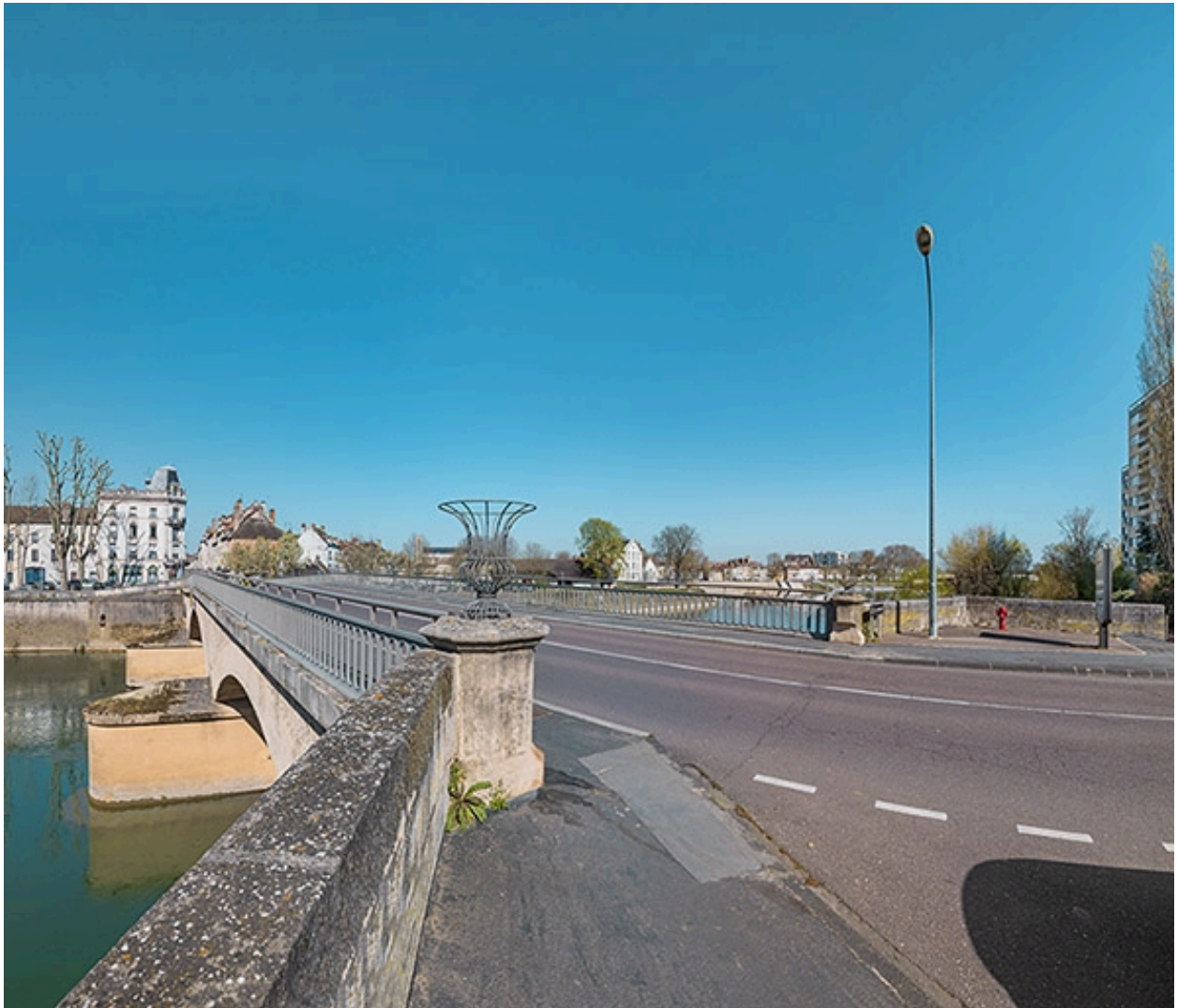
Vue d'ensemble du pont depuis la chaussée.
