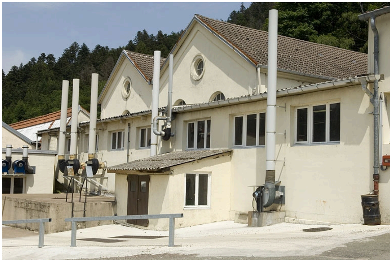
Anciennes chaufferie et salle des machines.
