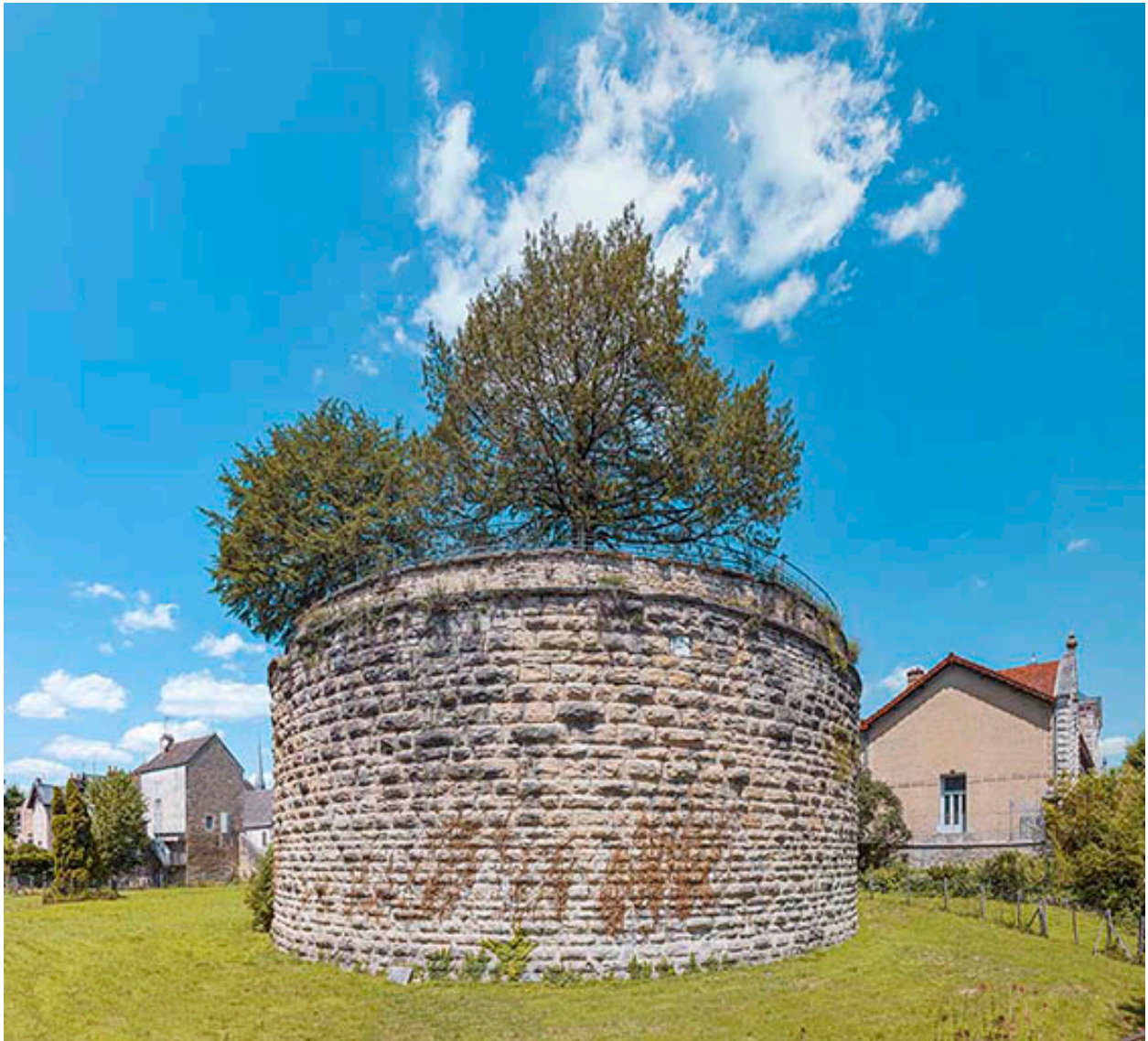
La tour depuis le fossé.
