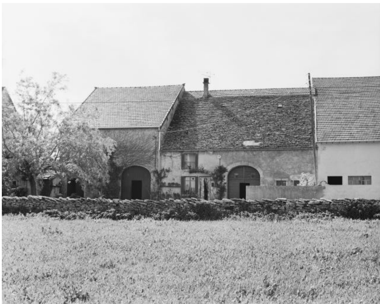
Granges-sur-Baume : ferme située route de la Mille.
