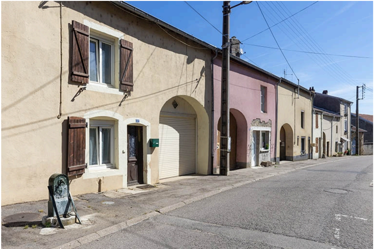
Rue Thiers, alignement du côté impair devant le n° 35, vue vers le nord-est.
