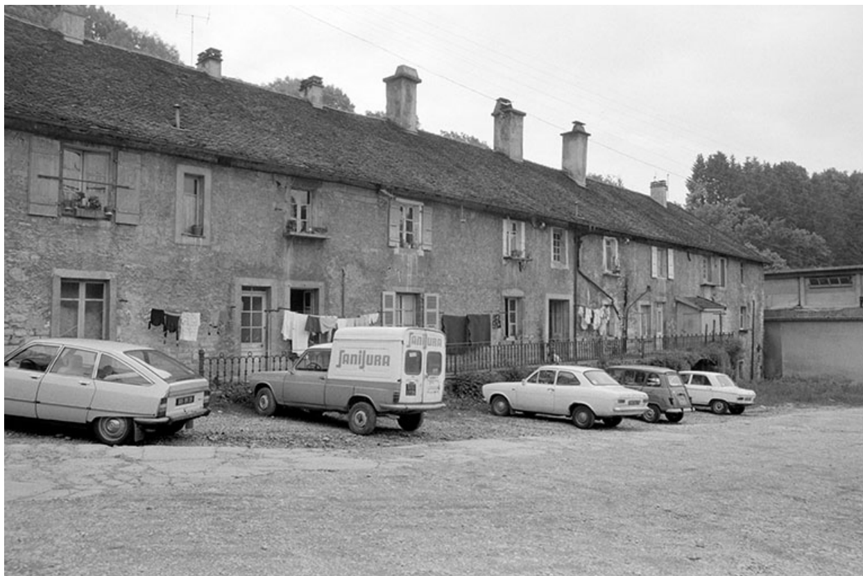
Logements d'ouvriers en 1980 : façade sur cour.
