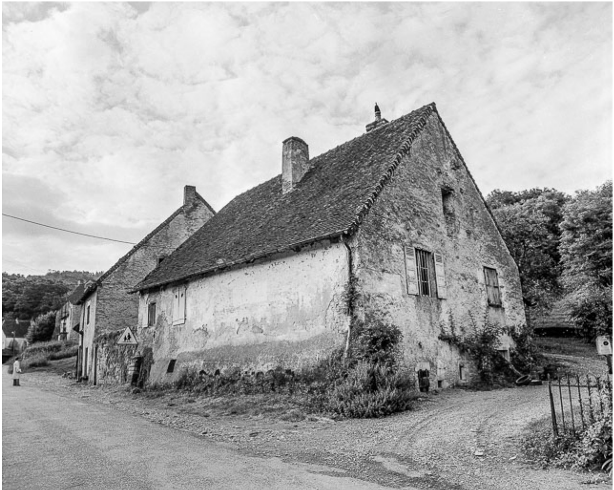
Façade antérieure et face droite.
