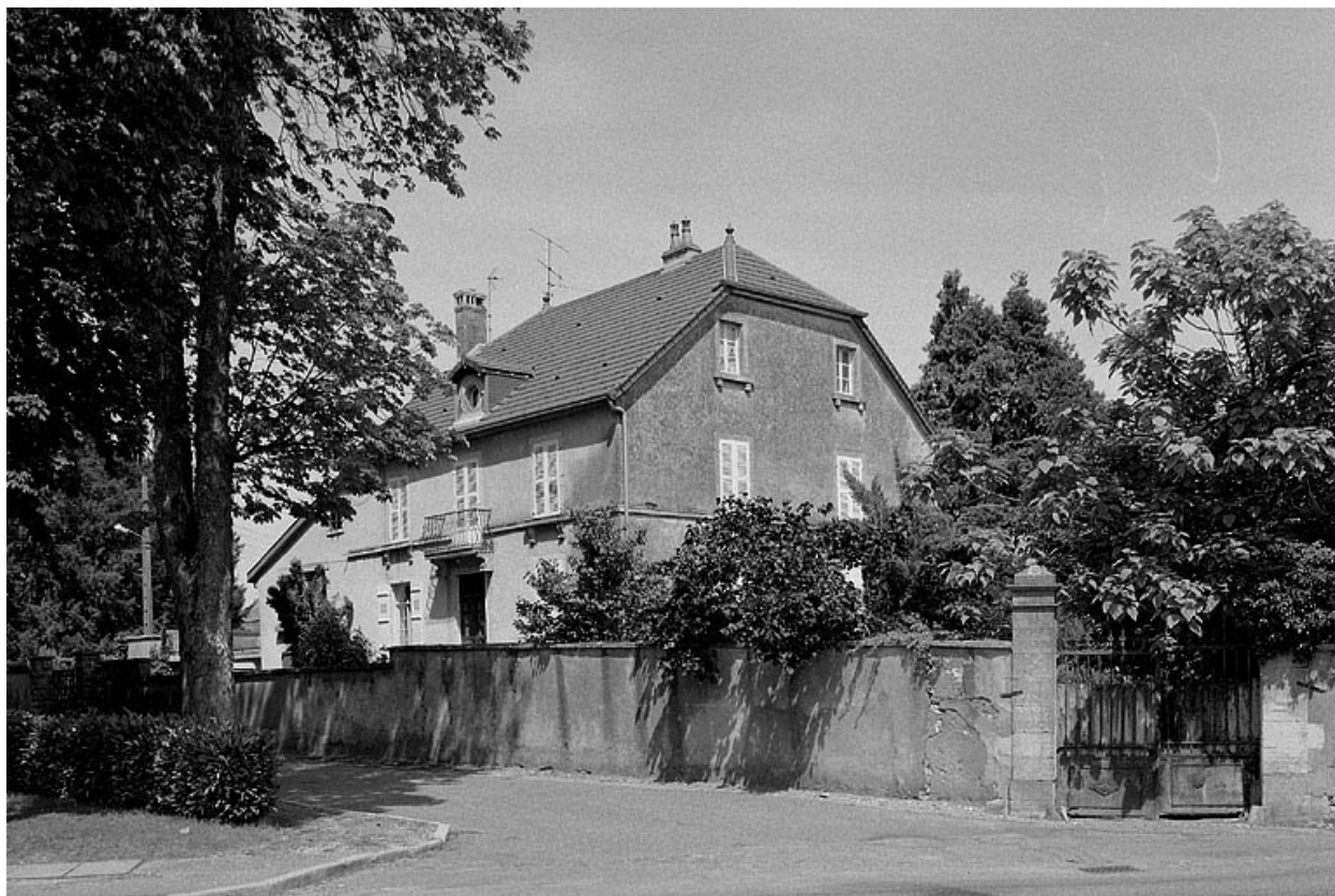
Maison située place de la République.
