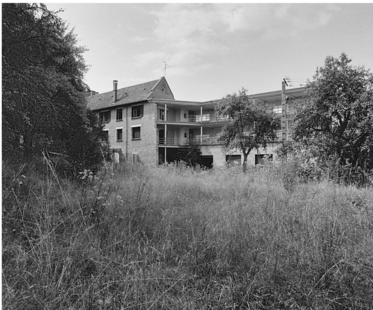
Galerie de cure est, façade sud-est.
