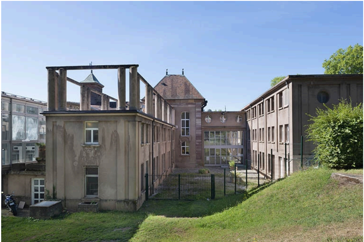
Aile ouest de la piscine couverte.
