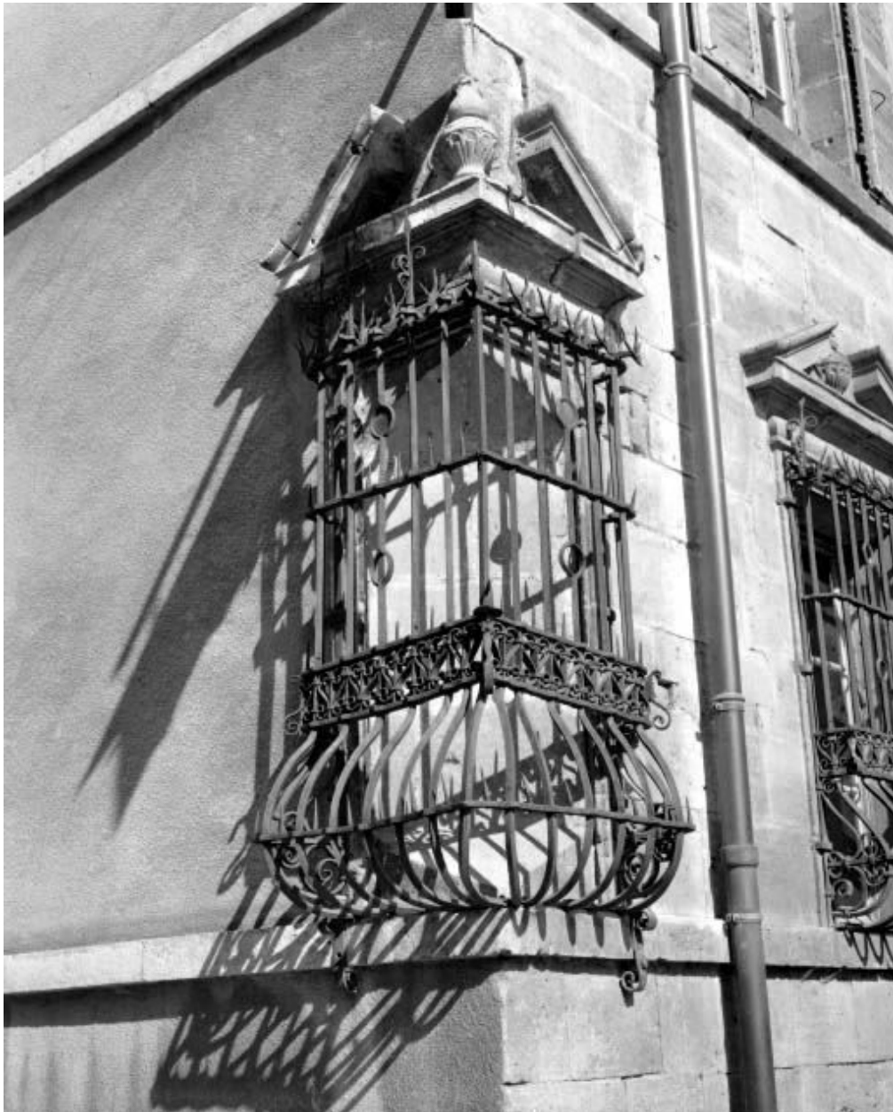
Façade antérieure, détail : baie d'angle du rez-de-chaussée.
