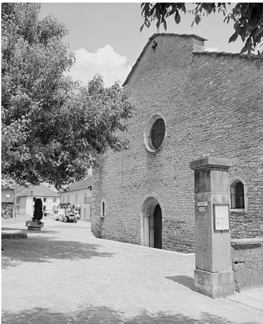
Façade ouest de l'église.
