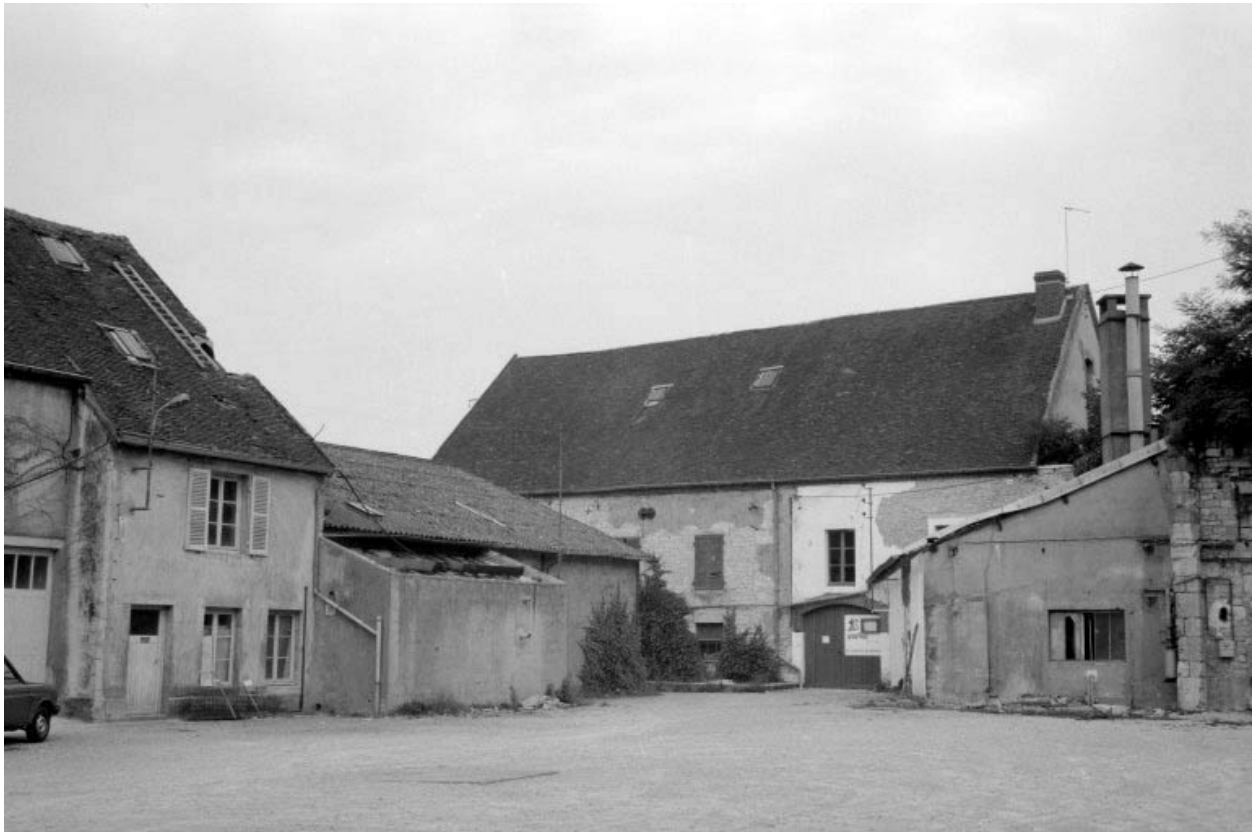
Ateliers de fabrication (H, J) et hangar.
