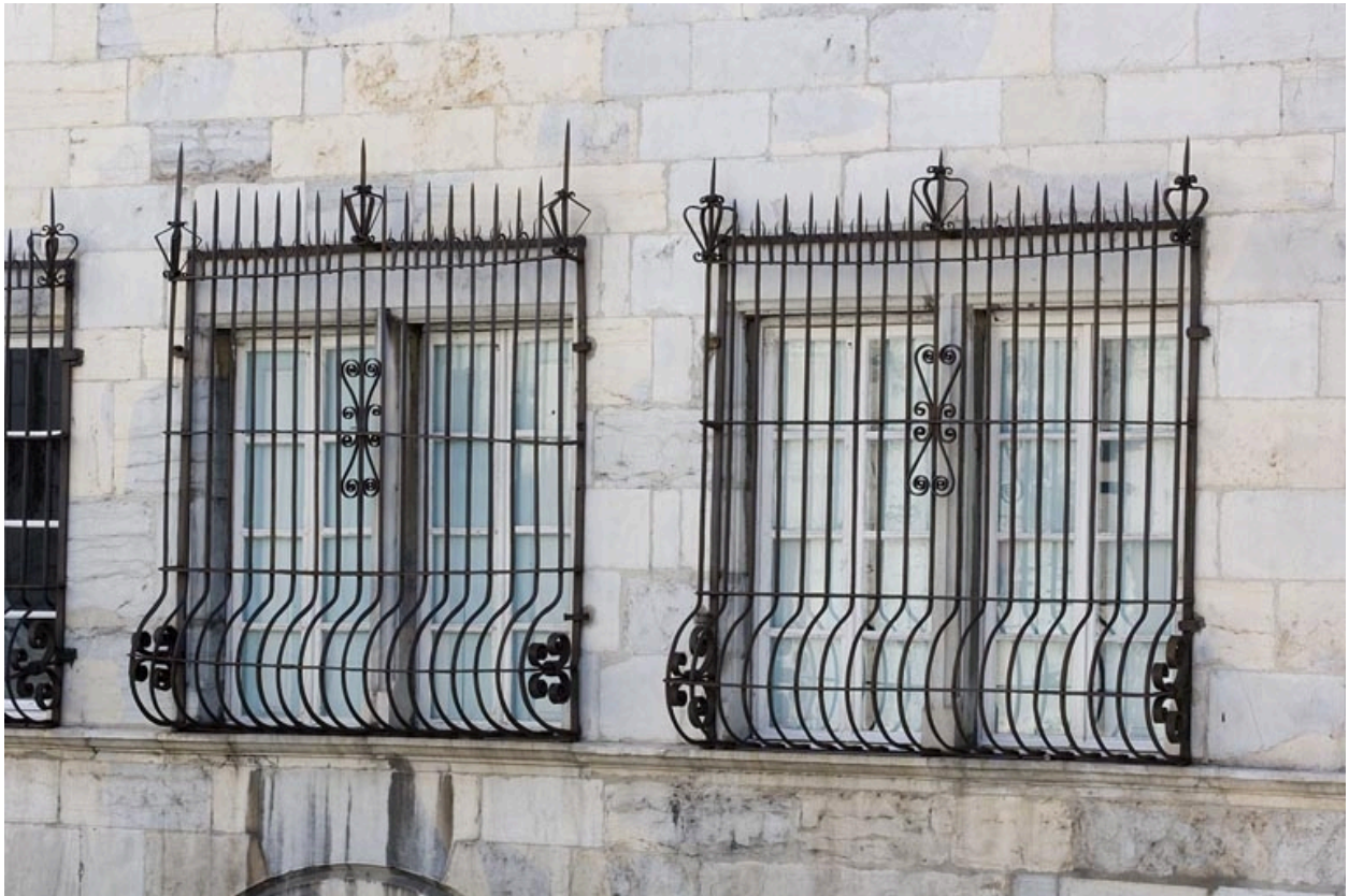
Détail de deux fenêtres du rez-de-chaussée avec leurs grilles.
