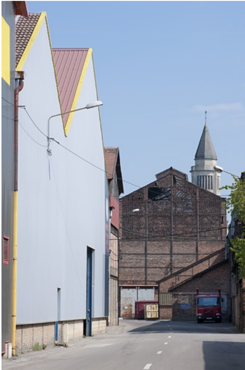
Pignons de l'atelier de laminage (tôlerie n°4) et du gazogène.
