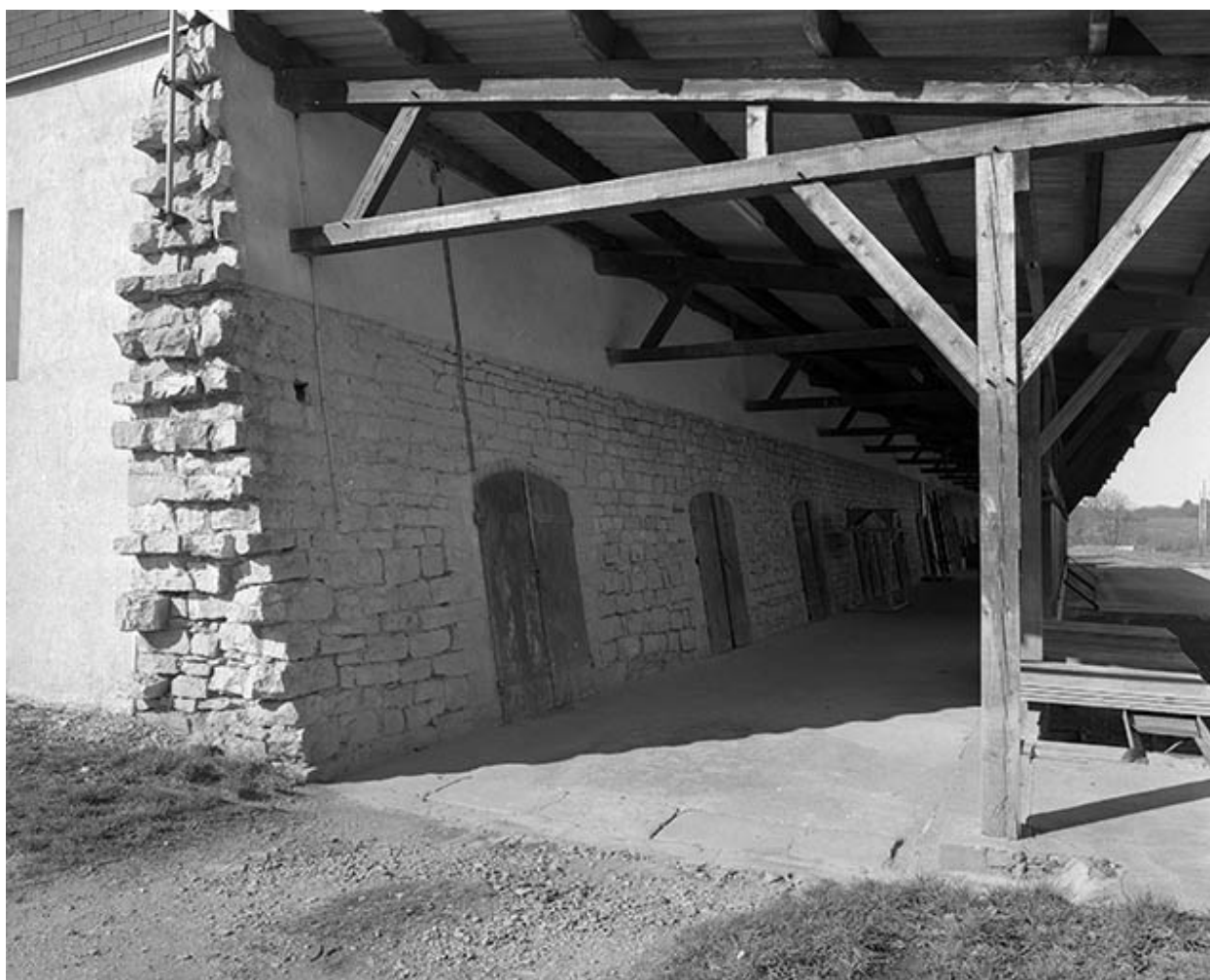
Mur nord du magasin industriel.
