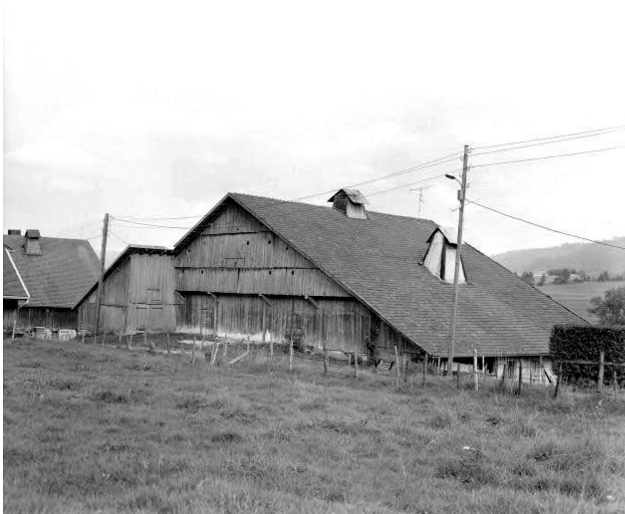
Façade ouest en 1976, de trois quarts droite.
