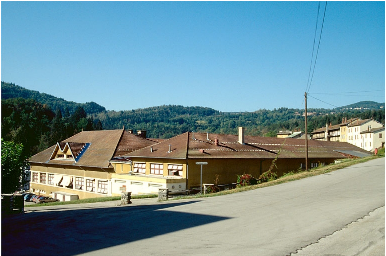
Nouvelle usine, vue depuis le nord-est.
