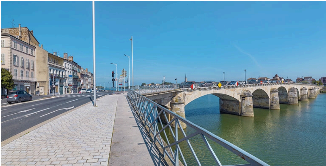
Le pont Saint-Laurent, vu d'aval, rive droite.
