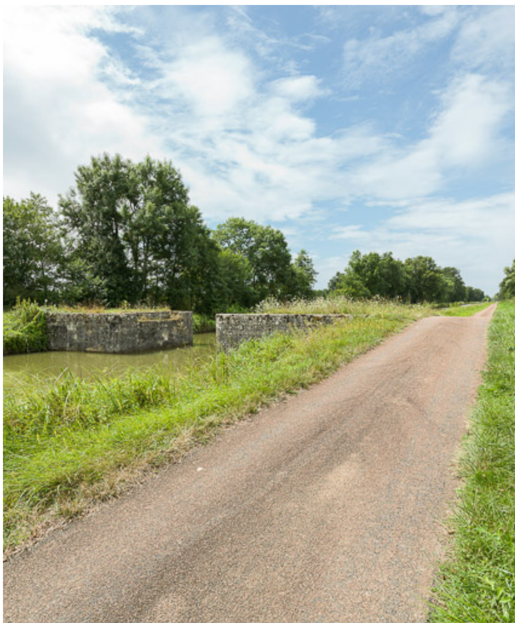
Vue du pont.
