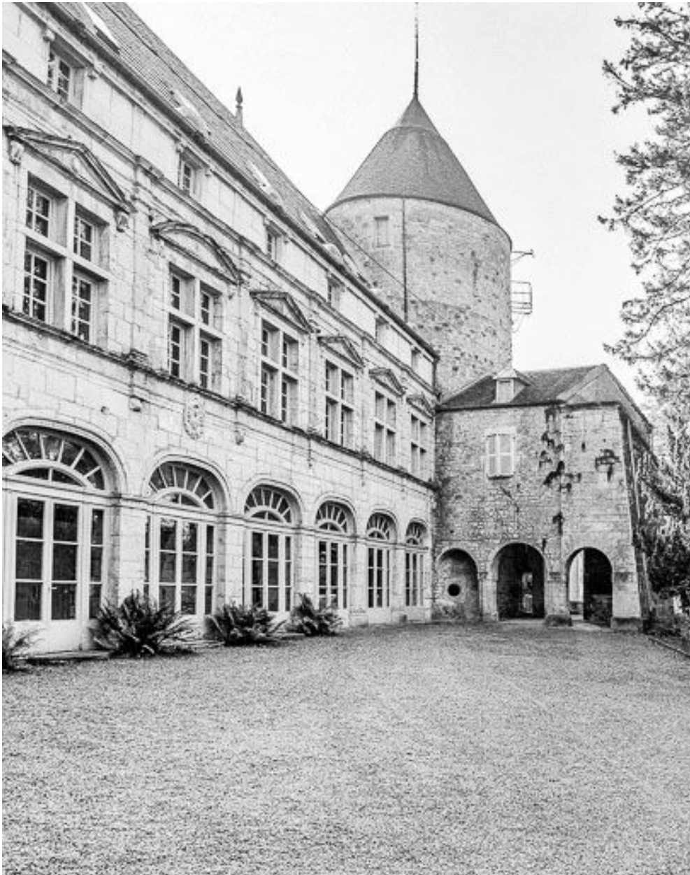
Façade sur cour : partie droite.
