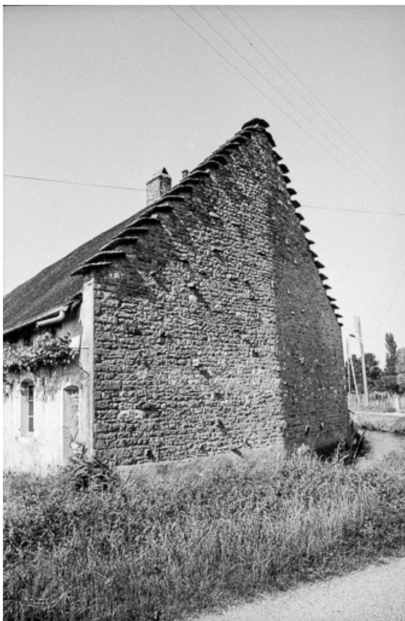
Maison cadastrée 1960 AH 102-104 : façade latérale.
