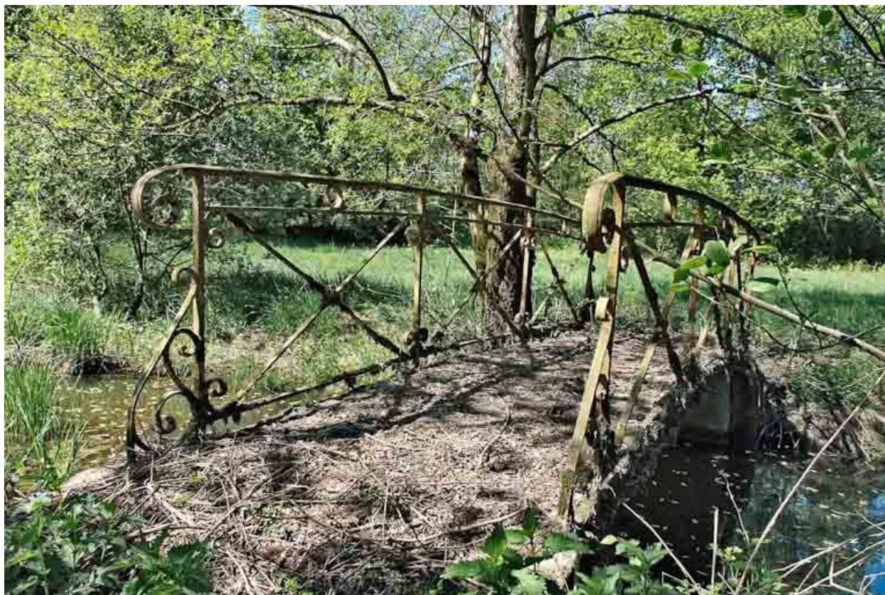
Passerelle métallique sur le Bief Michaud.
