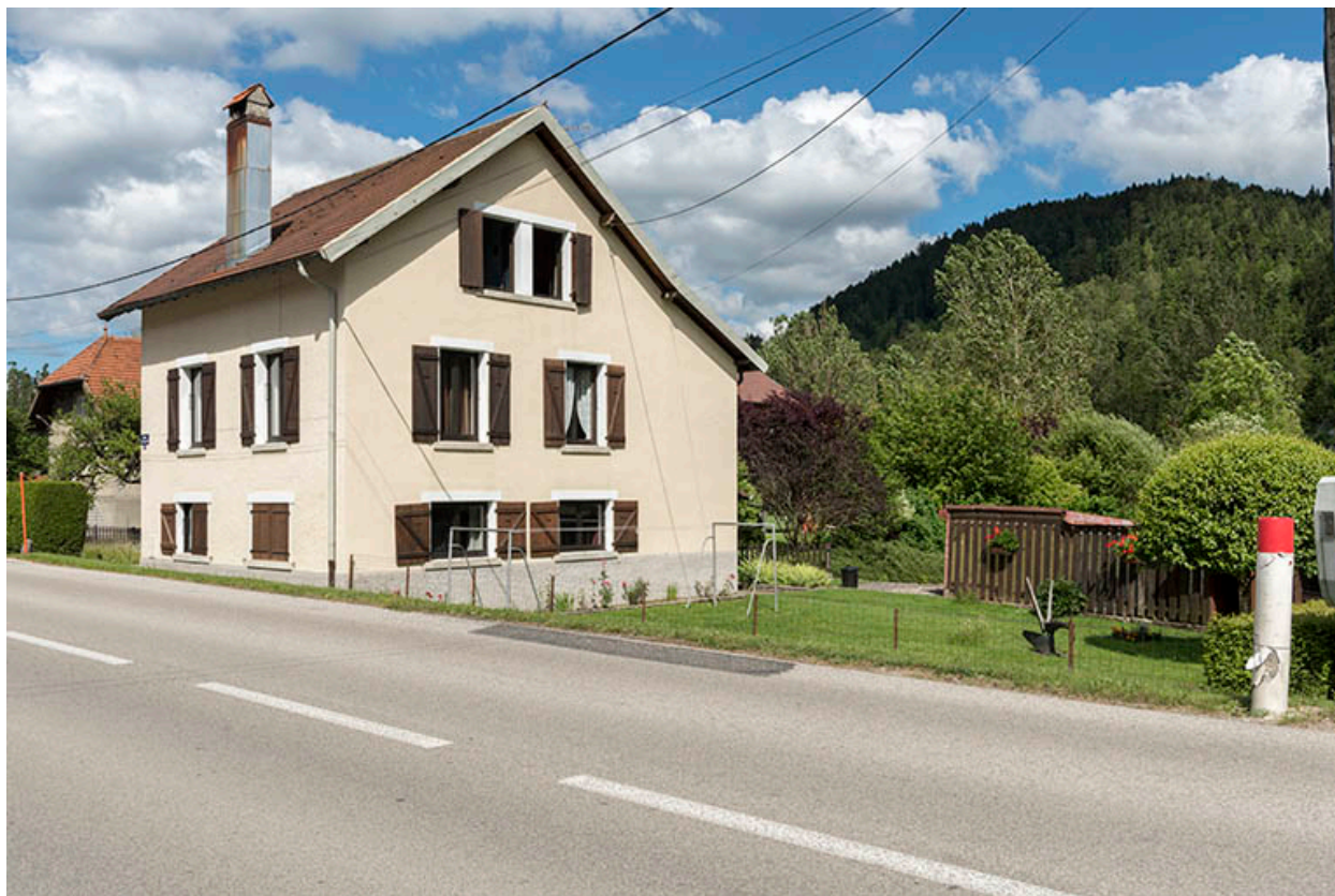
Façades antérieure et latérale droite.
