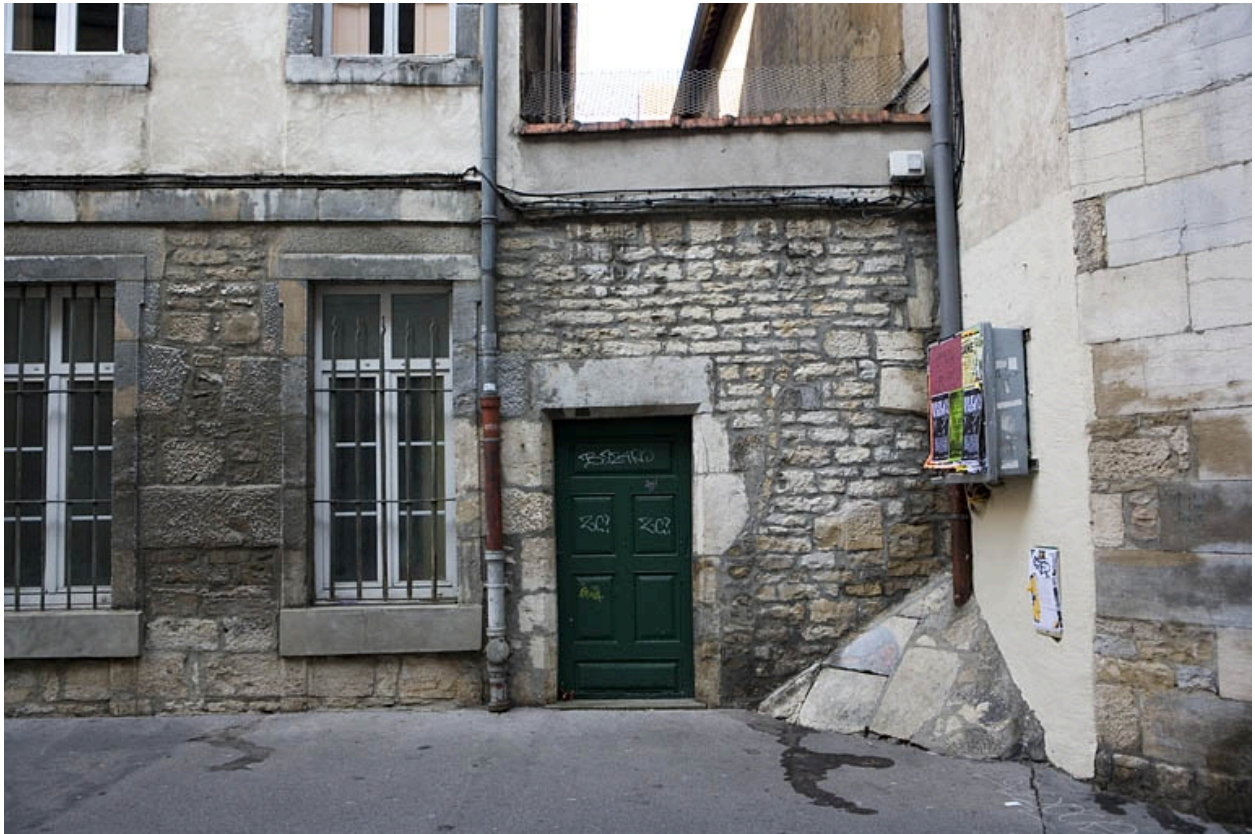
Détail de la porte secondaire située rue de la Bibliothèque.
