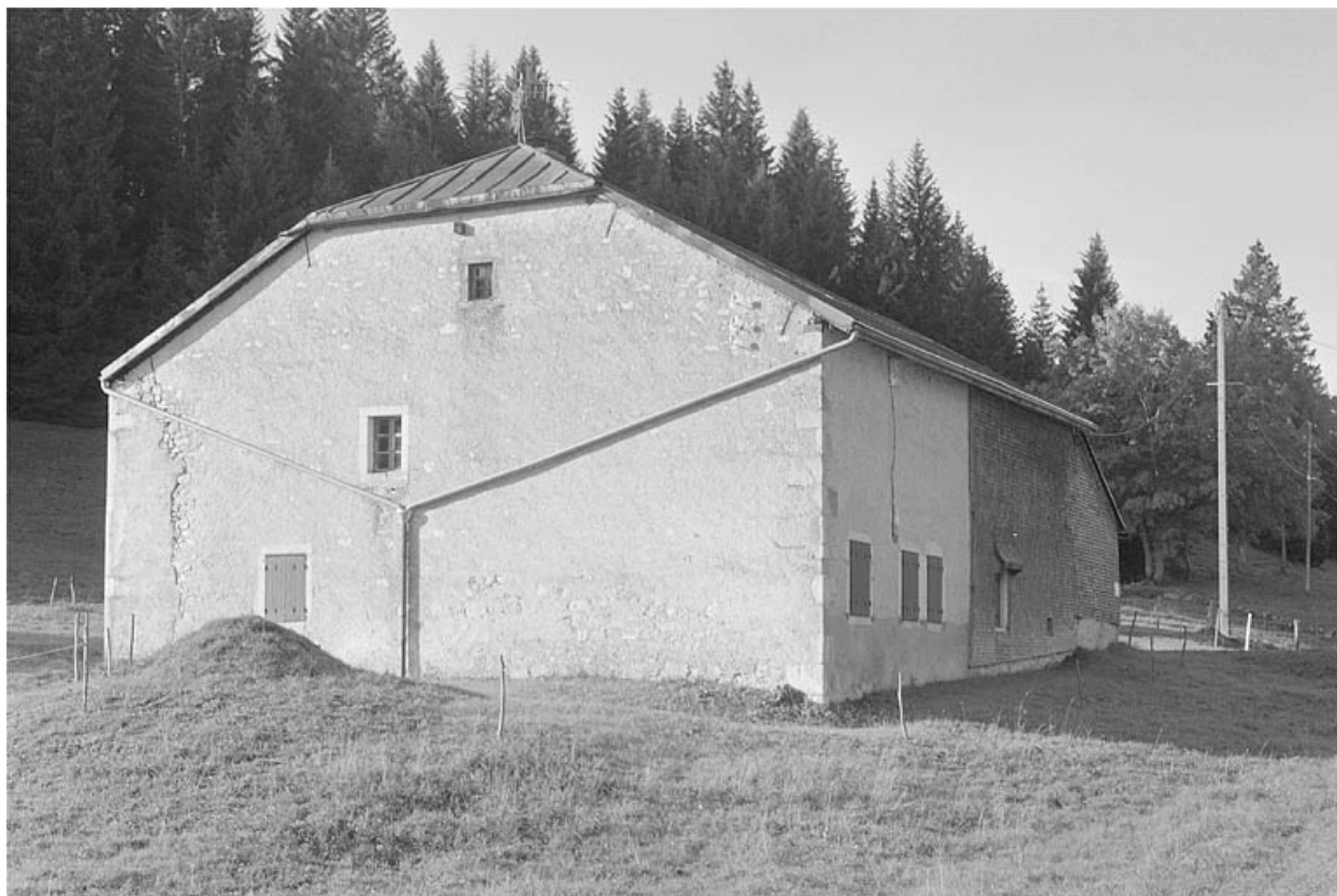
Face nord-est de la ferme et citerne.
