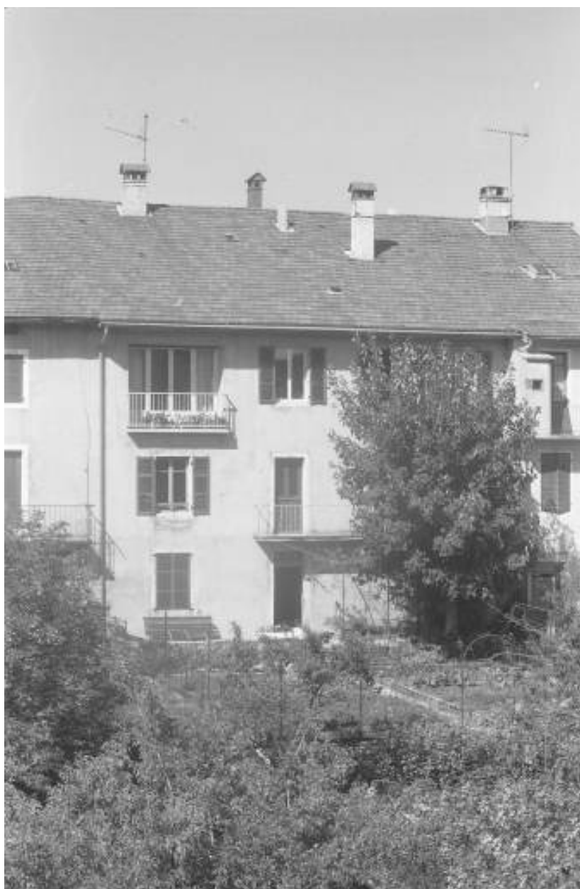
Vue rapprochée de la façade postérieure.
