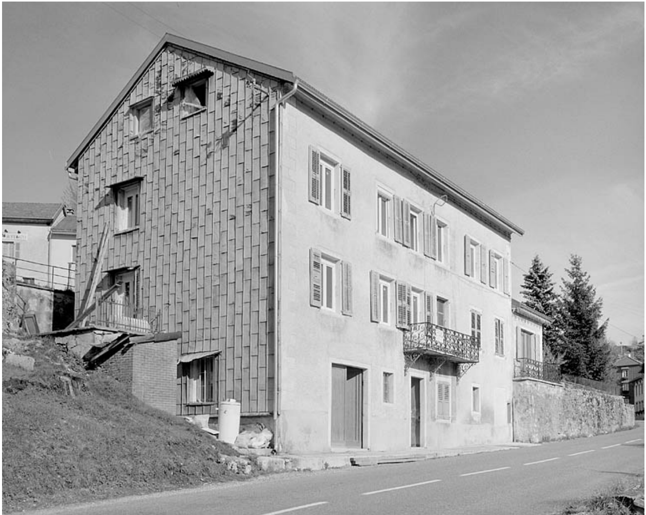
Façade antérieure et face sud-ouest.
