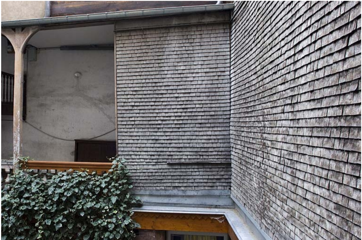
Ailes de l'escalier à cage ouverte et du passage cocher : détail de l'essentage en tavaillons.
