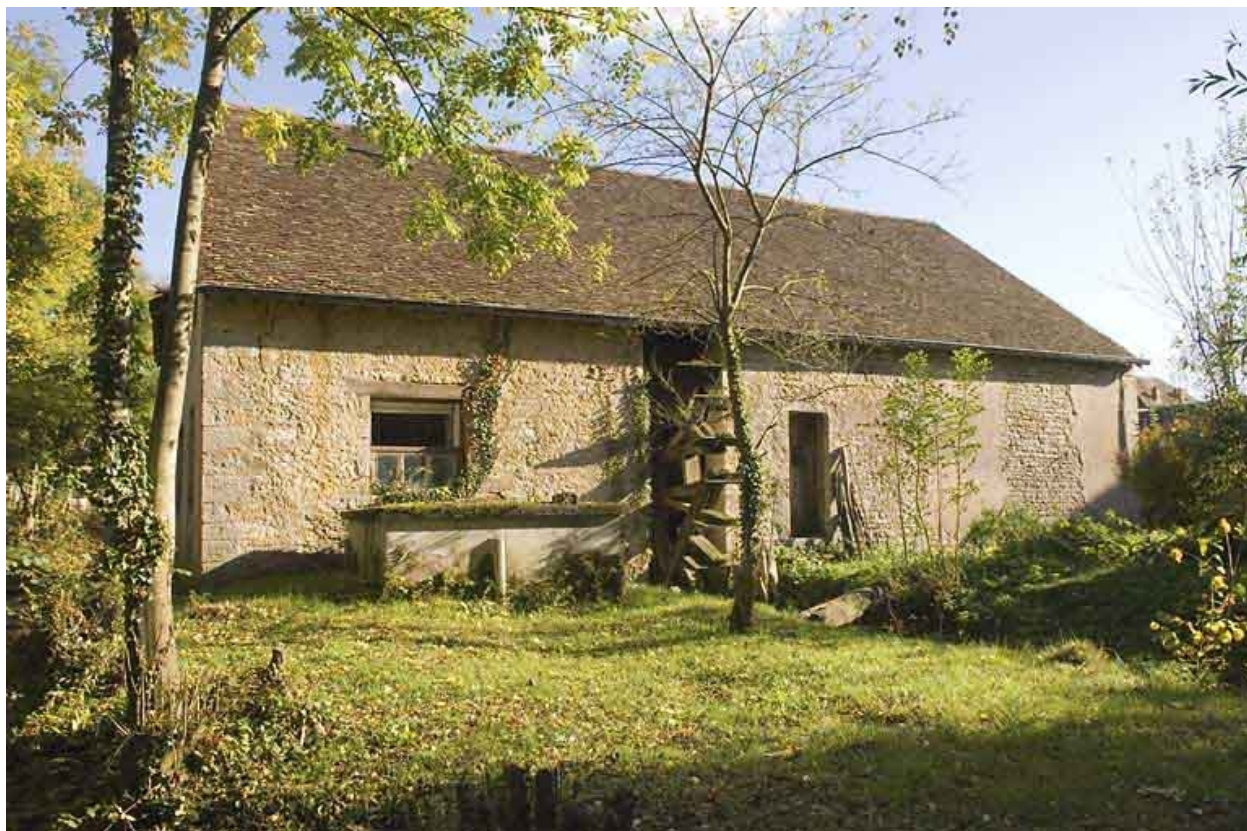
Façade postérieure du moulin.
