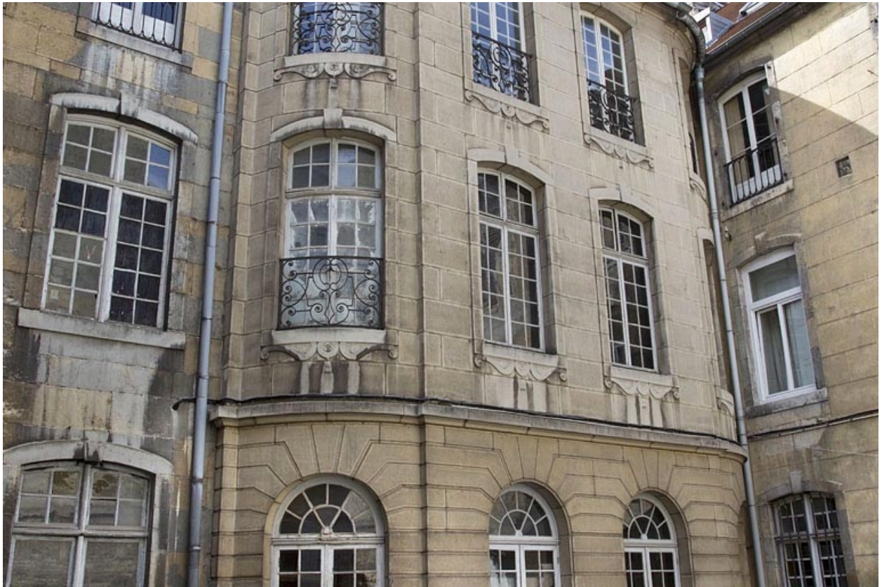
Aile de l'escalier : détail du premier étage.
