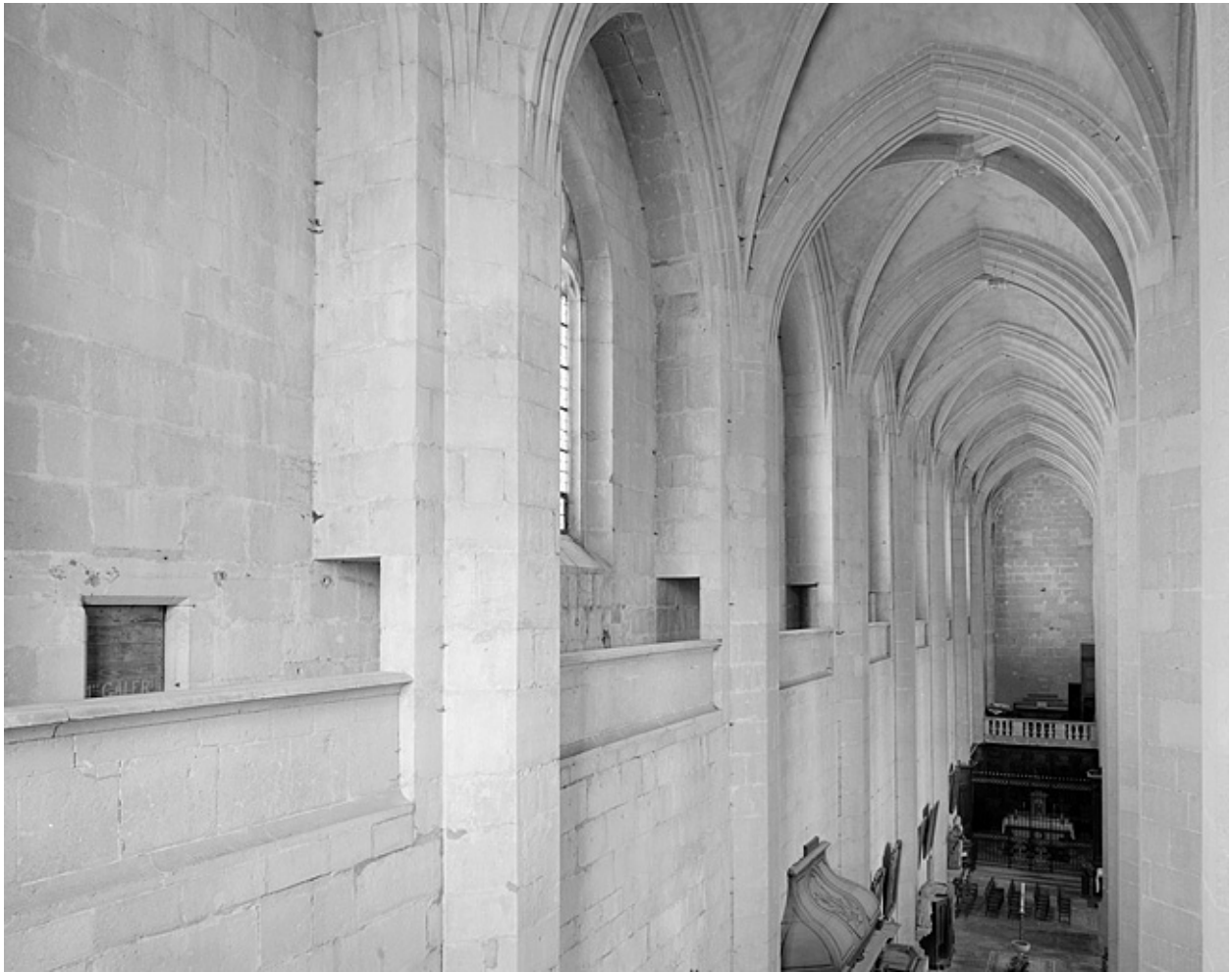
Vue latérale de la coursière du collatéral nord.
