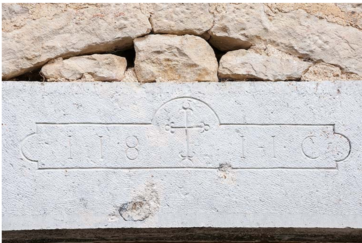
Détail d'un linteau de la façade sud.
