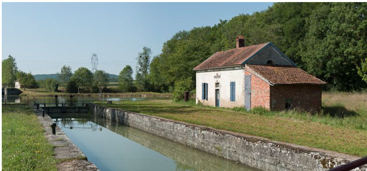
Vue d'ensemble du site d'écluse.
