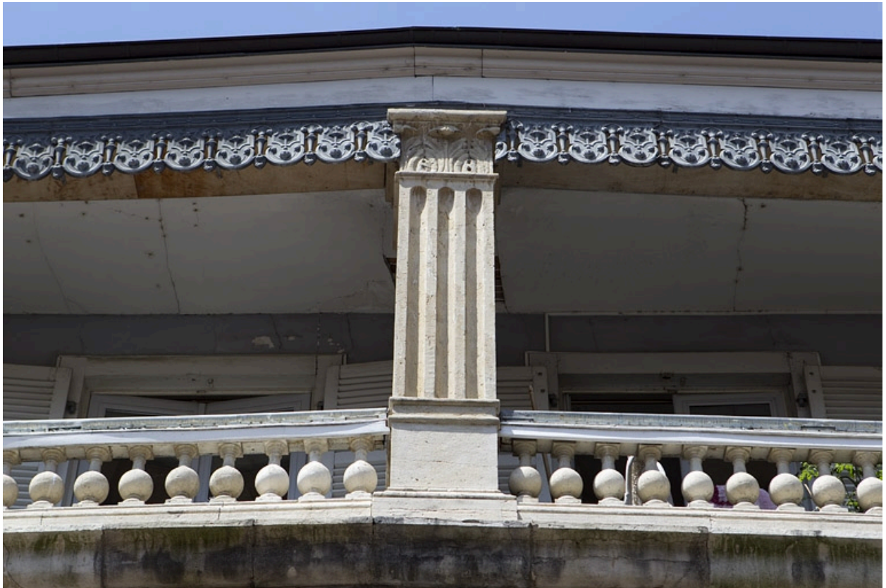
Façade sur rue du logis principal : détail de l'étage de surélévation, vue rapprochée, de face.
