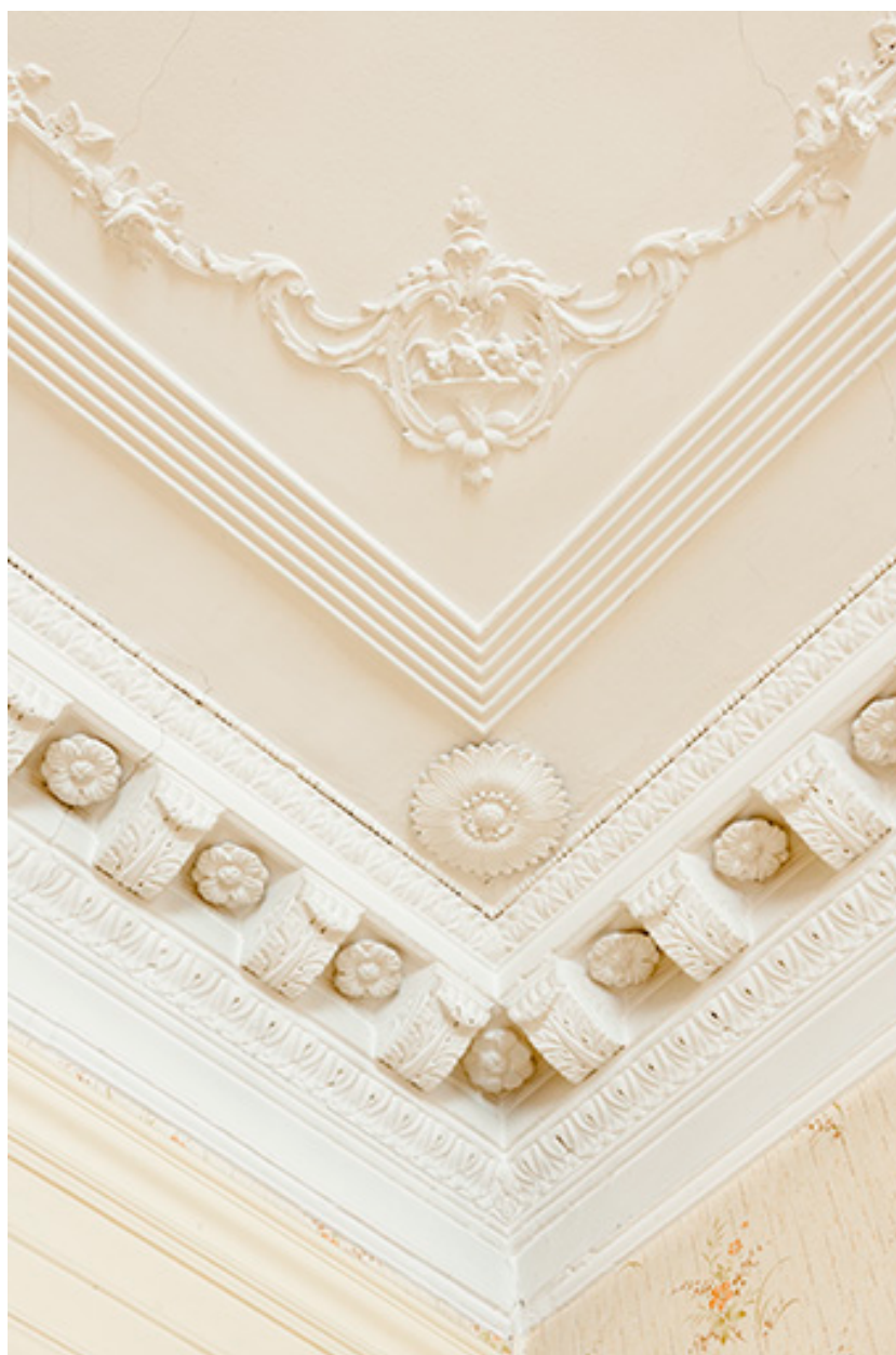
Détail du décor du plafond.
