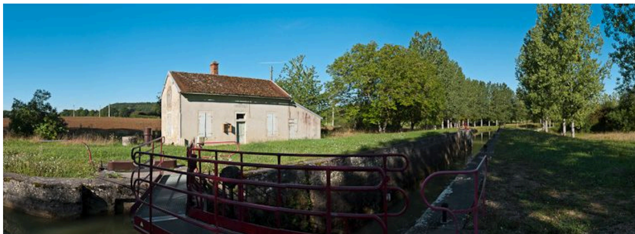
Vue d'ensemble du site d'écluse.
