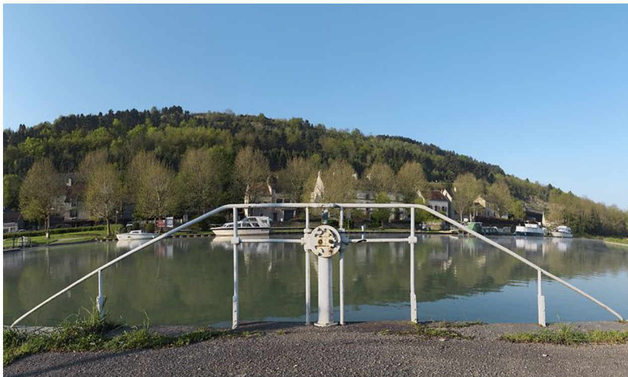
Vanne du déversoir.
