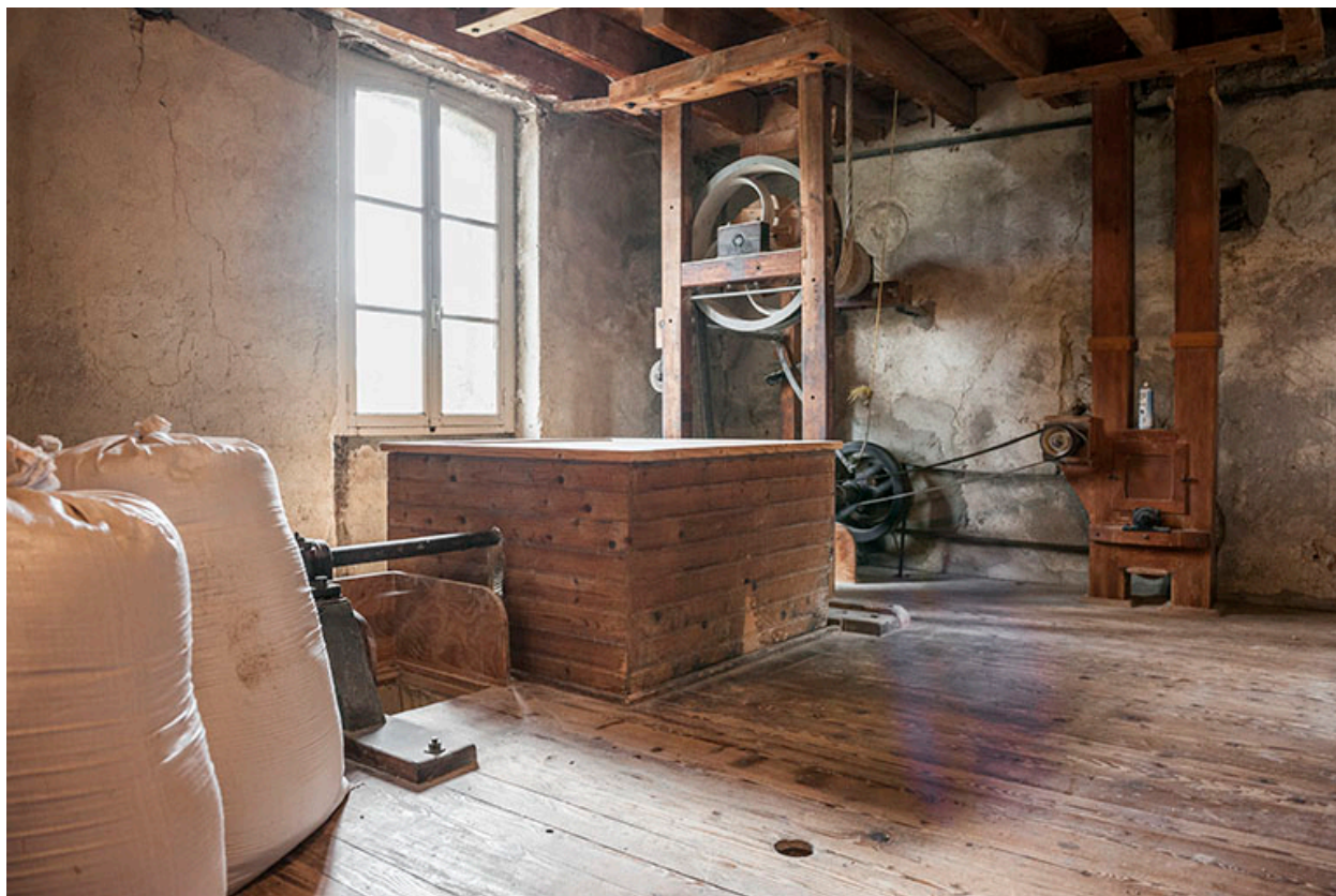
Deuxième étage. Coffre protégeant la transmission mécanique.
