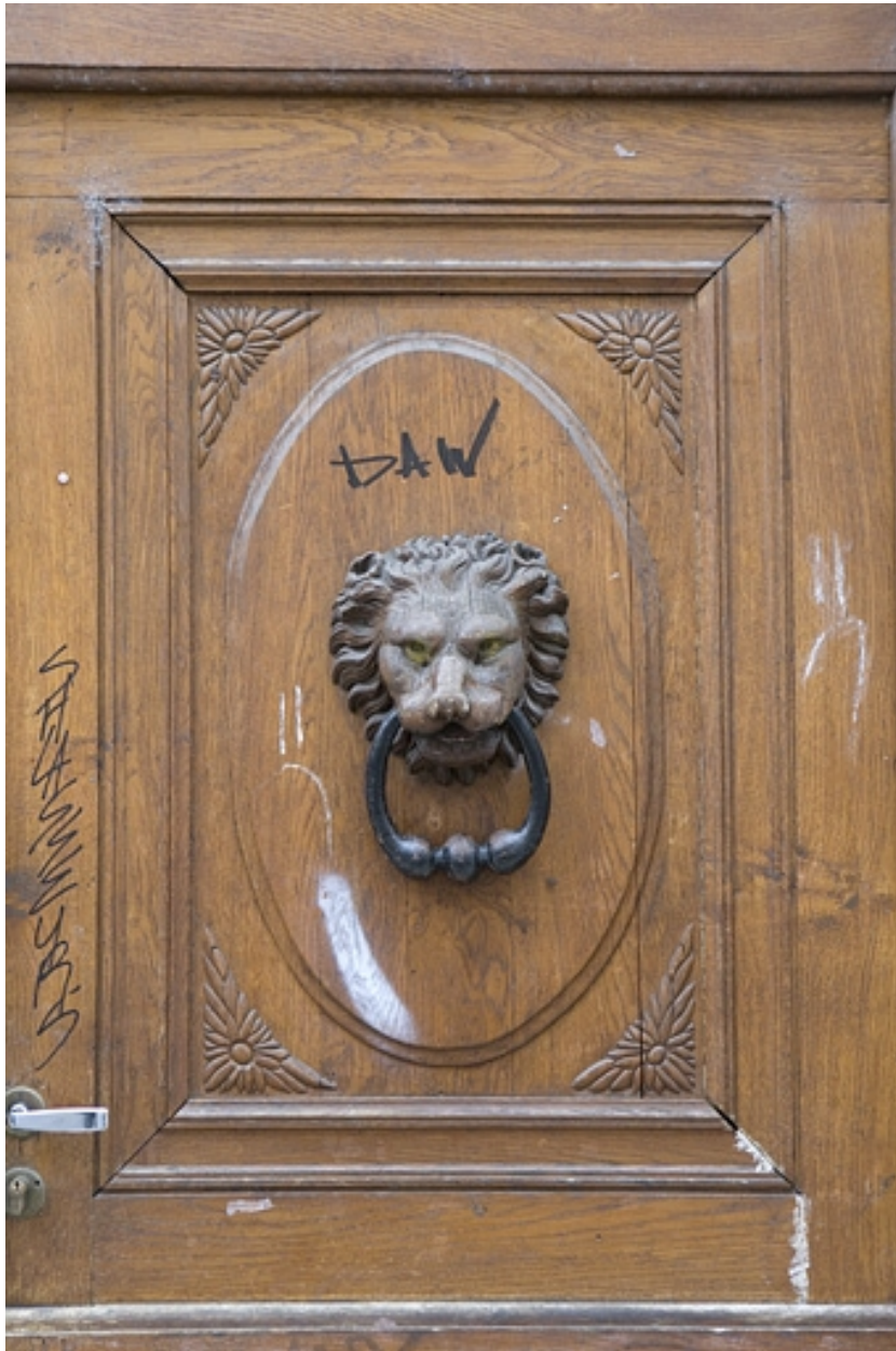
Vantail droit du portail d'entrée : détail du panneau central.
