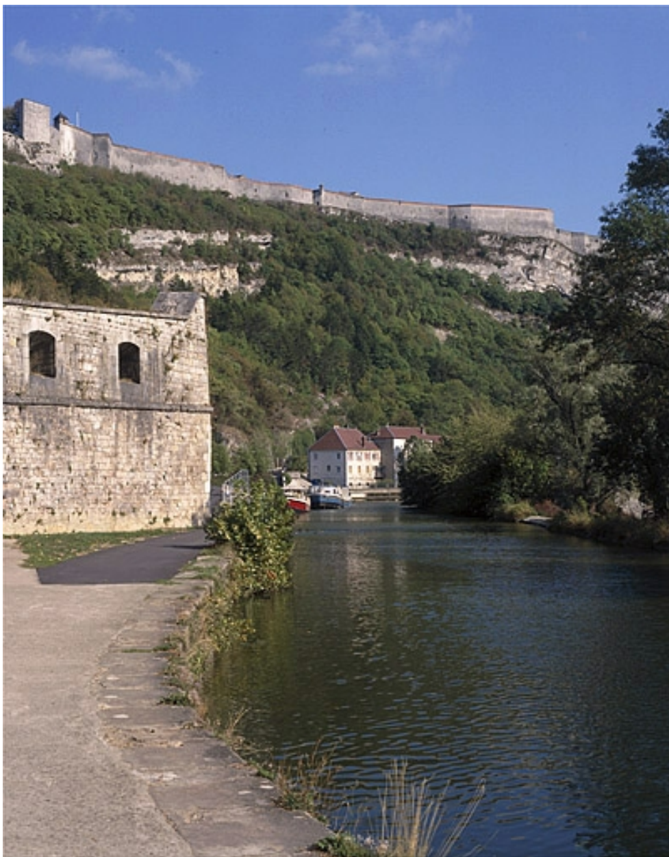
Vue d'ensemble depuis l'amont.
