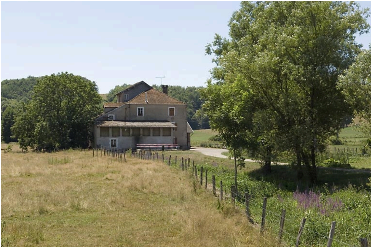
Vue depuis l'amont.
