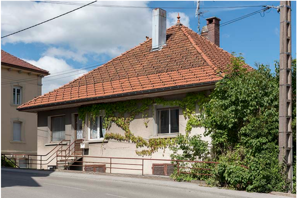
Façade postérieure (rue du Maréchal Foch).
